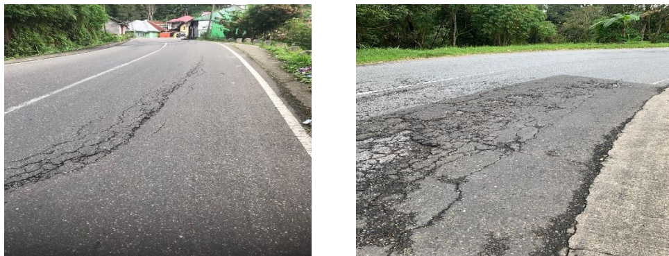
Gambar 1.3 Retak Memanjang
