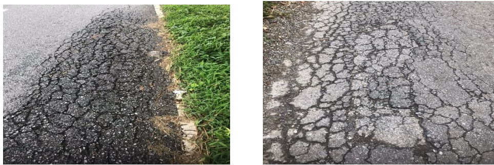
Gambar 1.2 Retak Kulit Buaya
